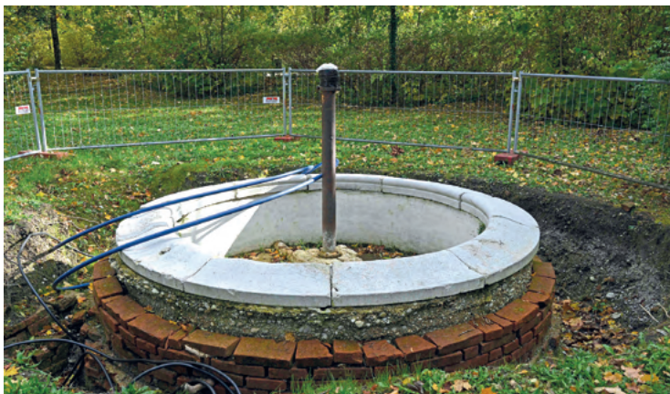
Nach historischem Vorbild restauriert und wiederhergestellt wird der alte Brunnen im Schlosspark.
